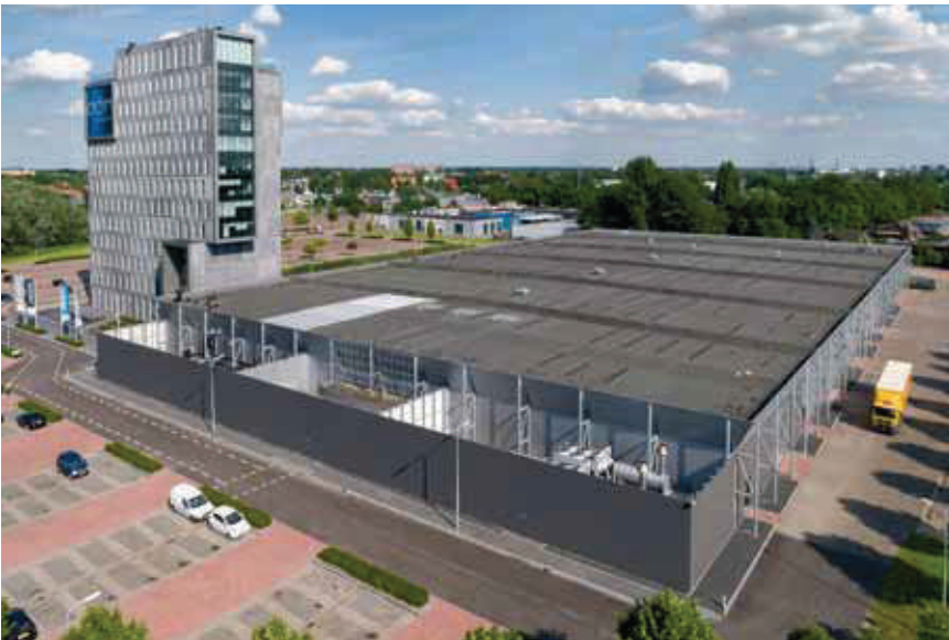
Figuur 4: BREEAM-gecertificeerd datacenter.
