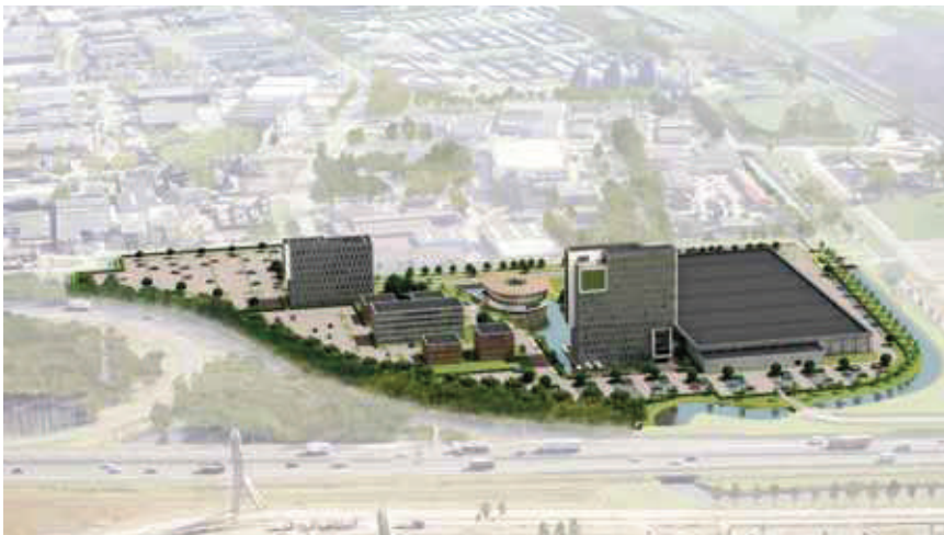
Figuur 2: Expo Business Park Hengelo, waar Previder het eerste BREEAM-NL Excellent datacenter (4 sterren) heeft gerealiseerd.
